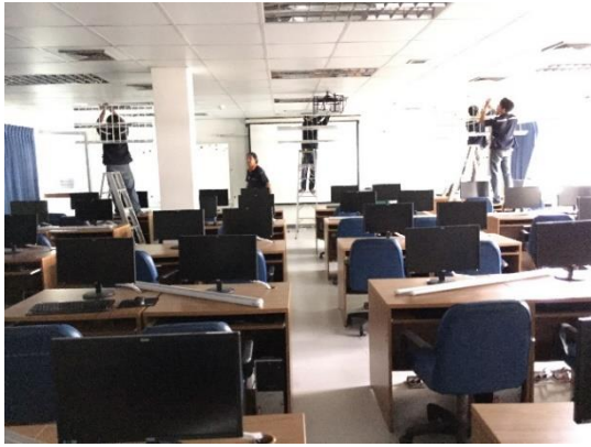
ติดตั้งหลอด LED ในห้องสมุดและห้อง LAB
