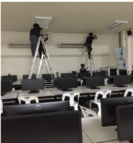
ติดตั้งหลอด LED ศูนย์คอมพิวเตอร์
