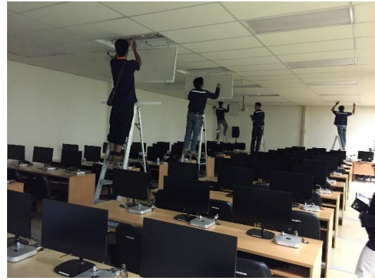
ติดตั้งหลอด LED ในห้องสมุดและห้อง LAB
